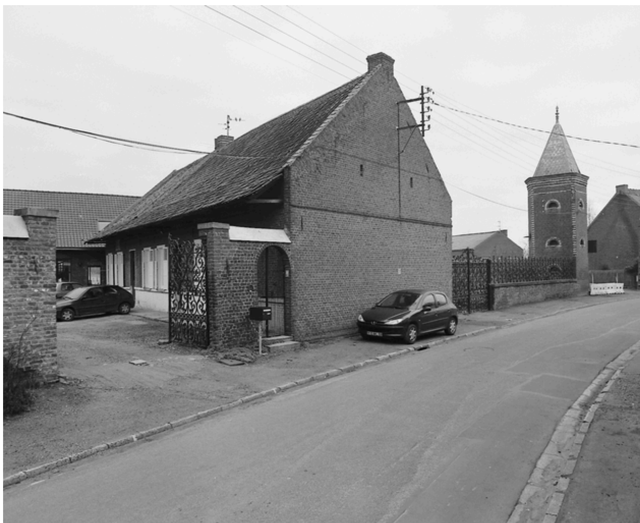
Ferme, 135, rue Neuve.
