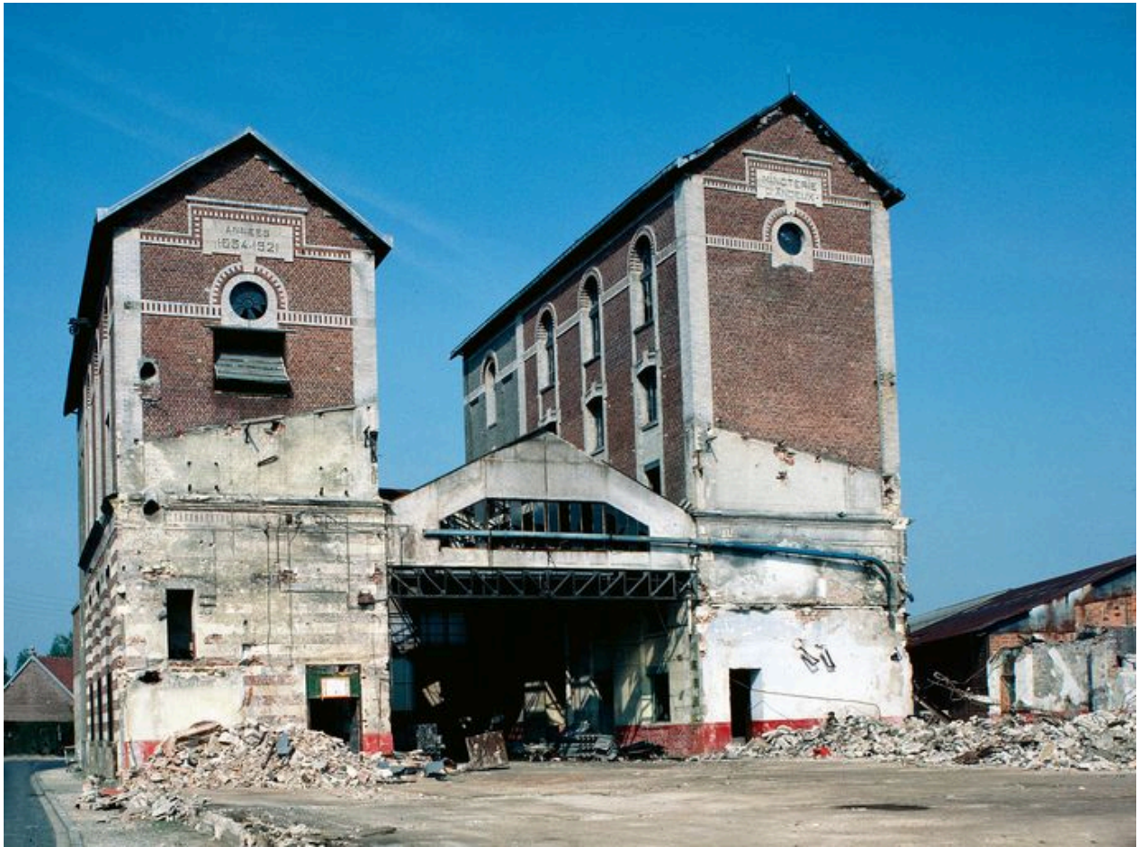
Vue en cours de destruction.
