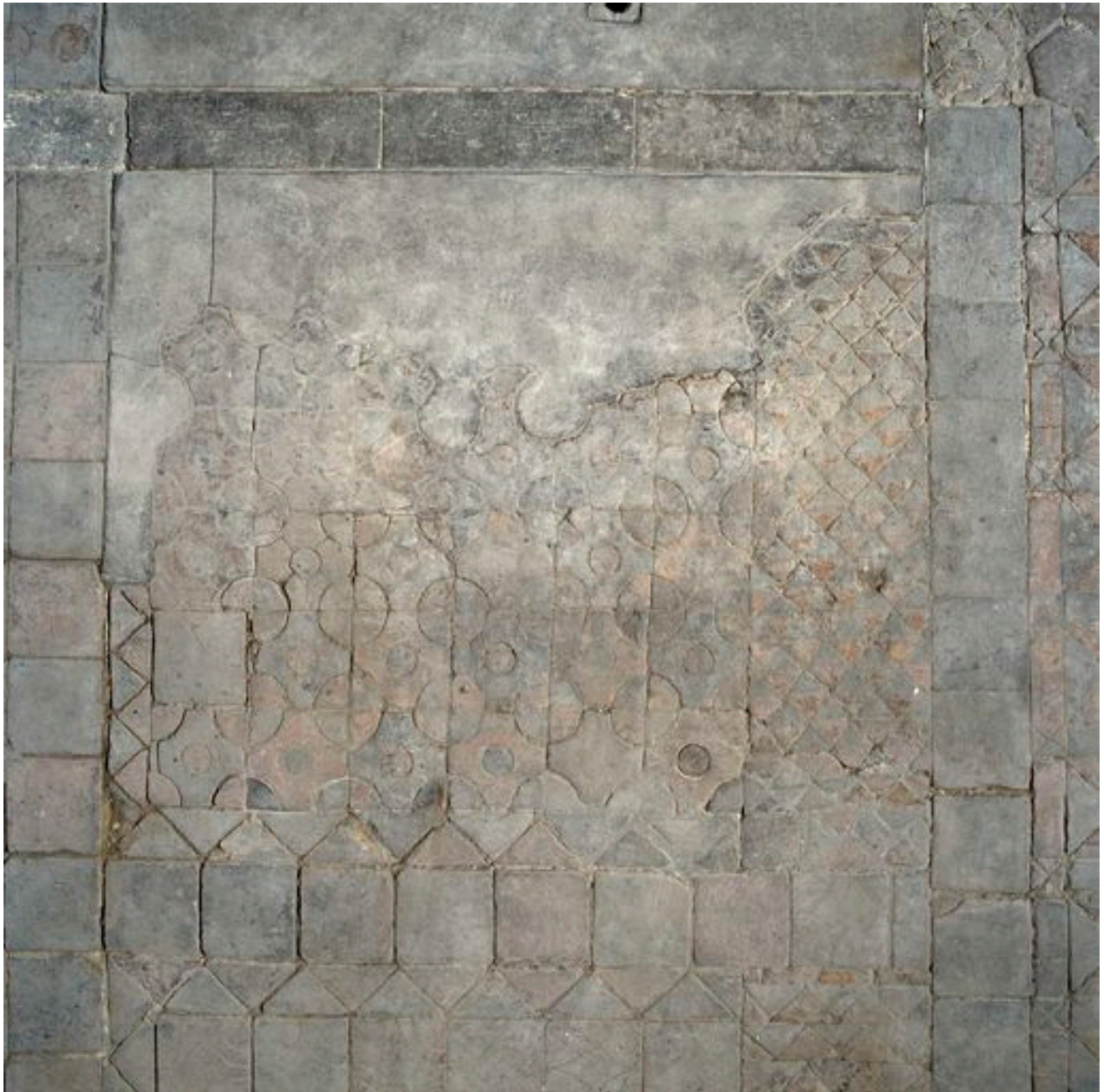
Détail du carrelage.
