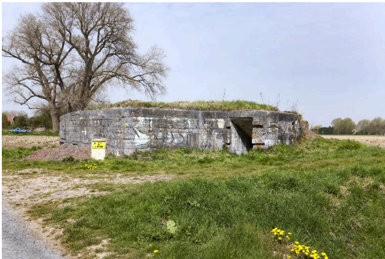
Vue générale vers le nord-est
