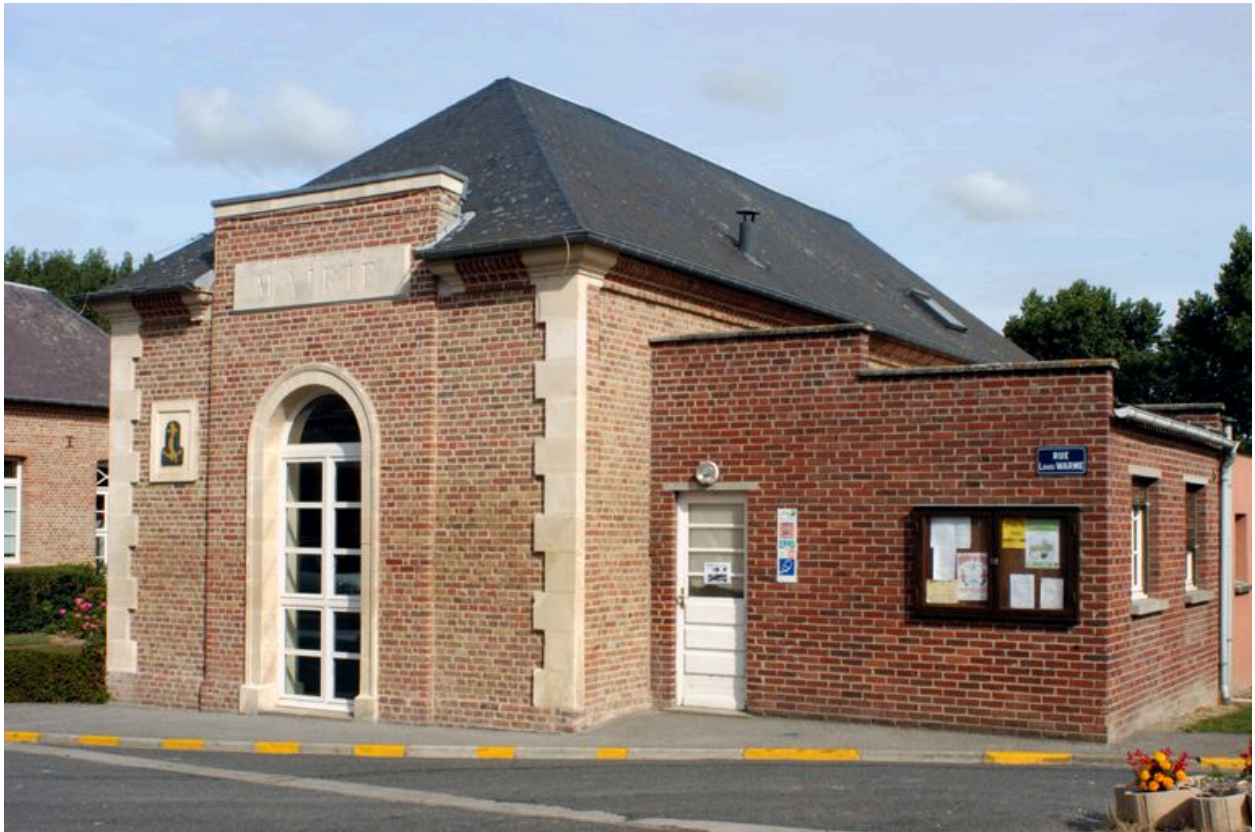
La mairie, vue du sud-est.
