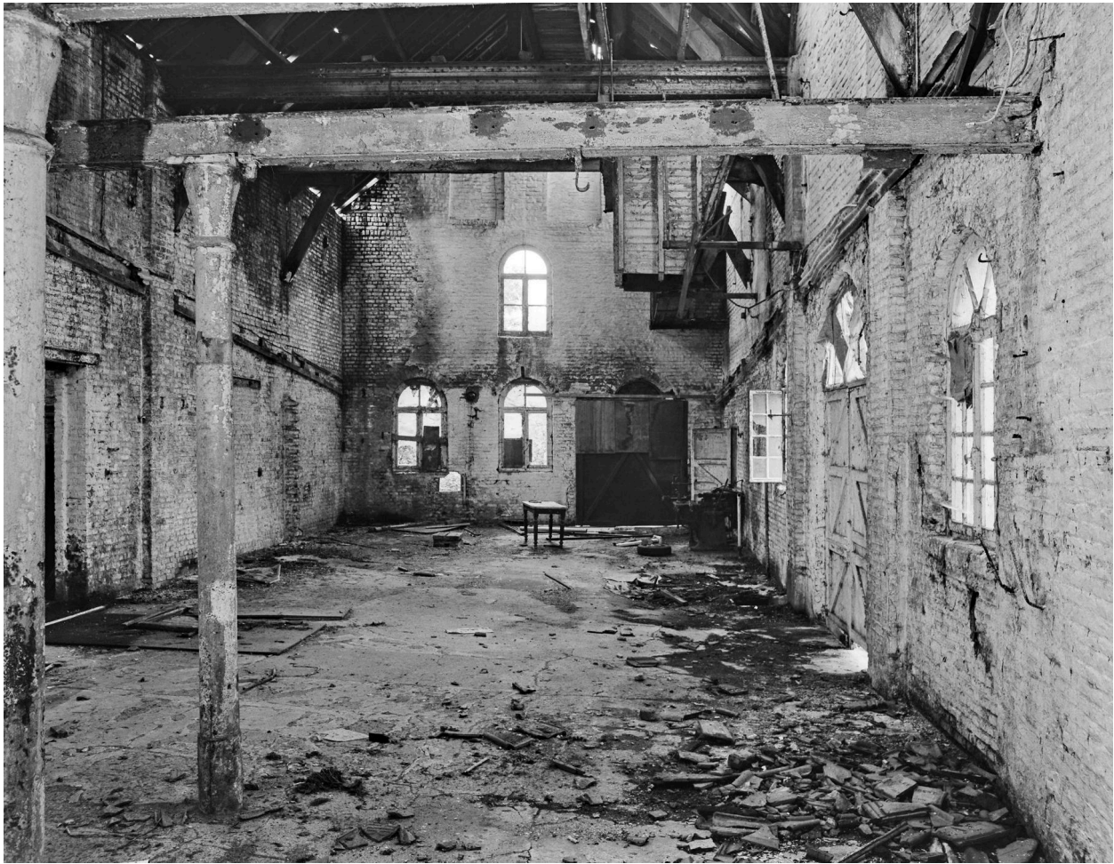
Vue longitudinale de l'intérieur de la brasserie.
