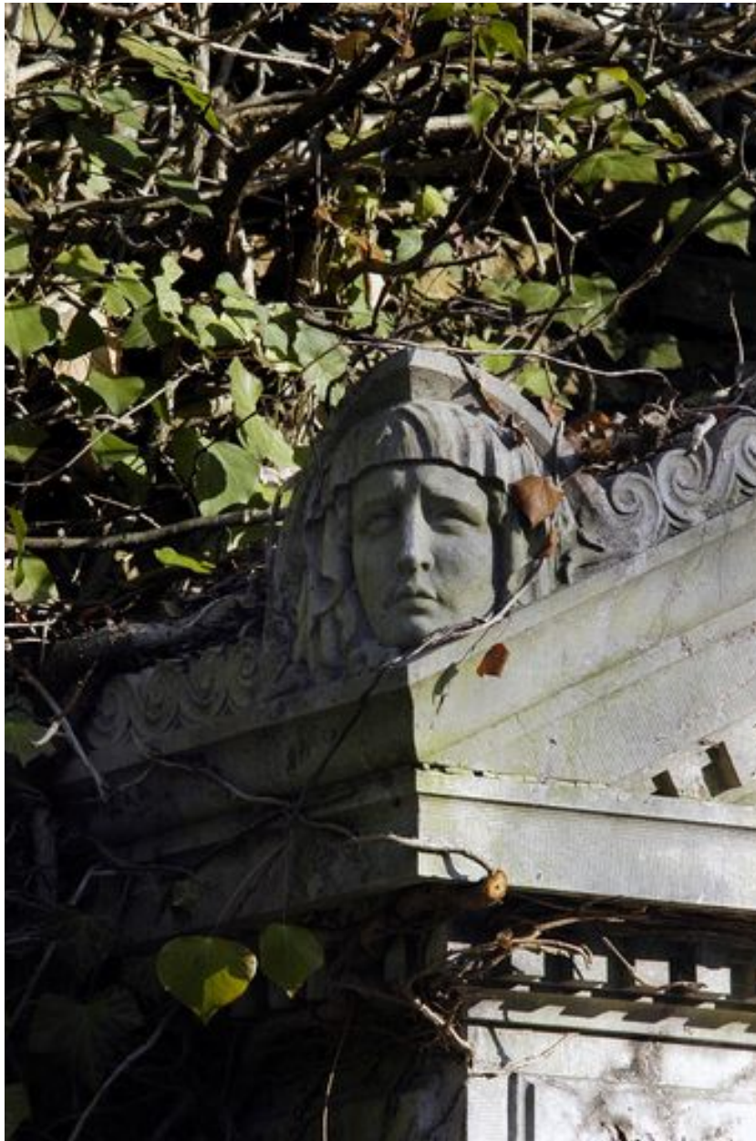
Détail d'un des acrotères.
