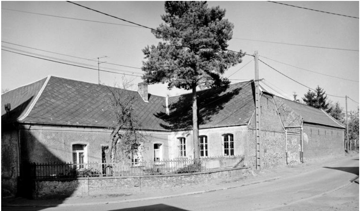
Vue partielle du logis, et de l'élévation sur rue de l'étable.
