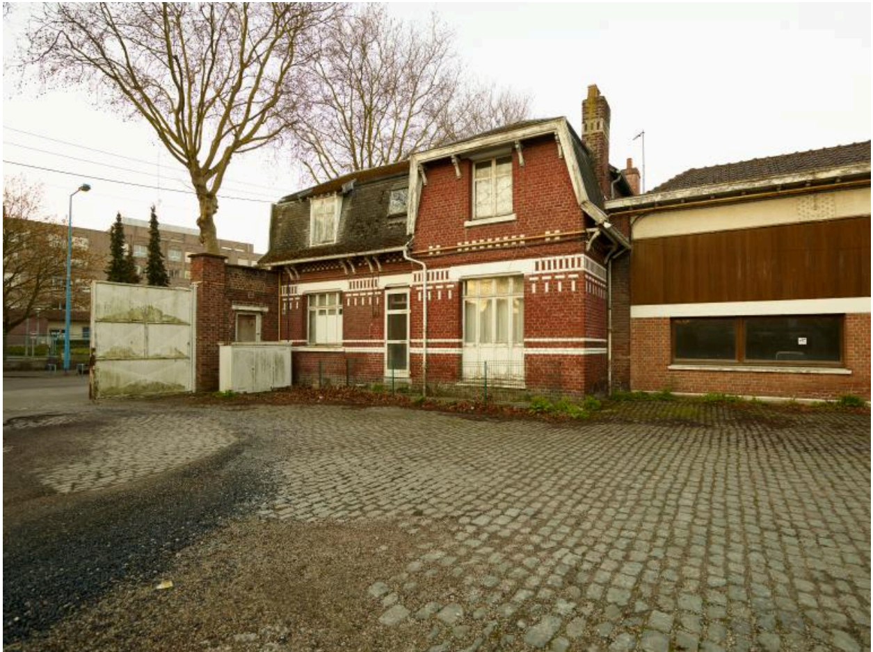
Conciergerie ouest (ancien garage). Vue prise vers le sud, depuis la cour.
