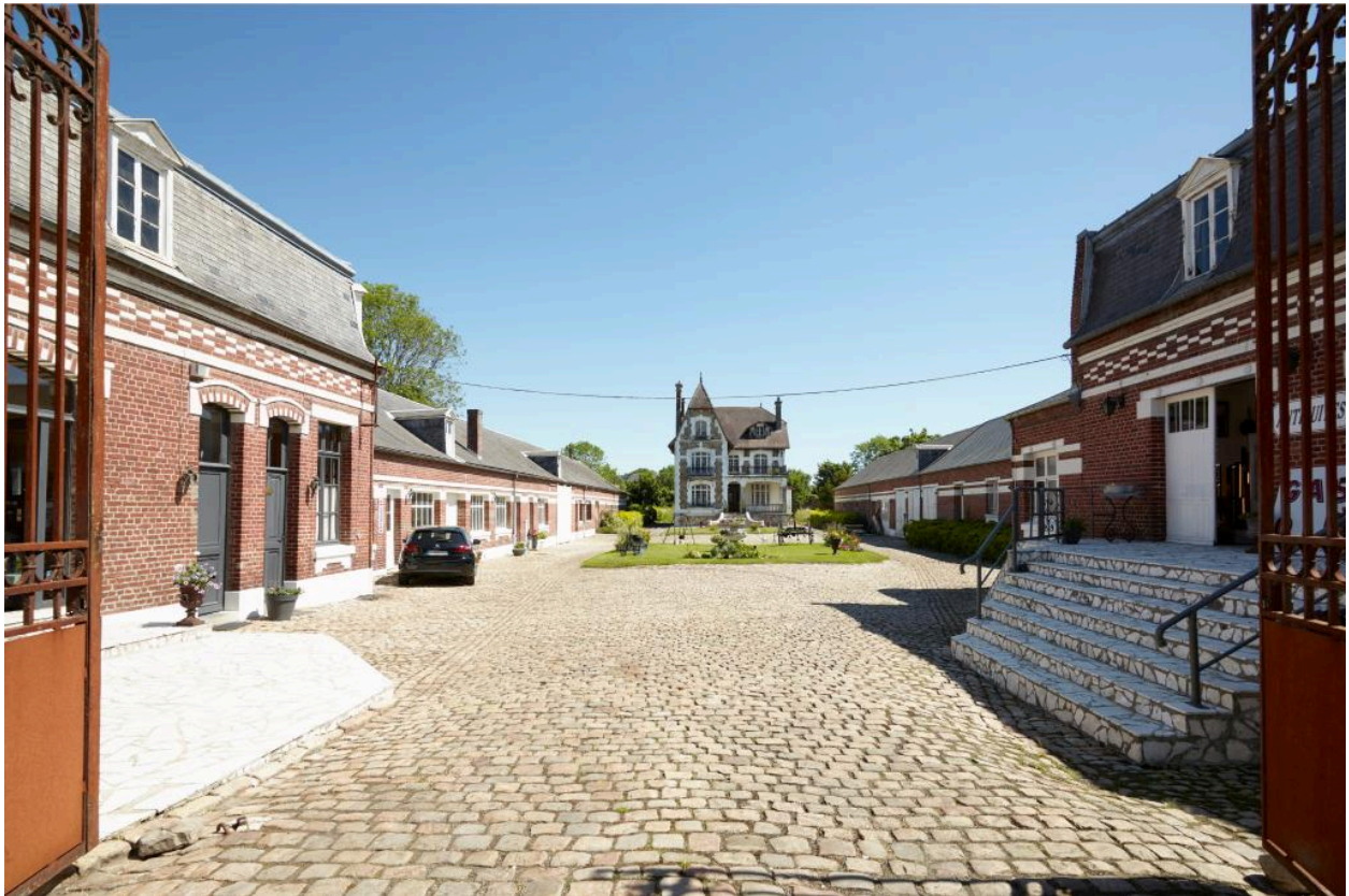
Vue générale depuis l'entrée de la cour.
