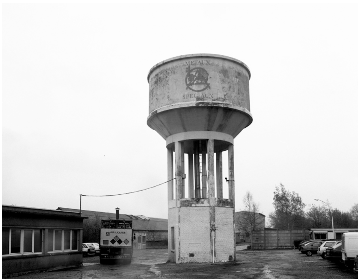
Le château d'eau.
