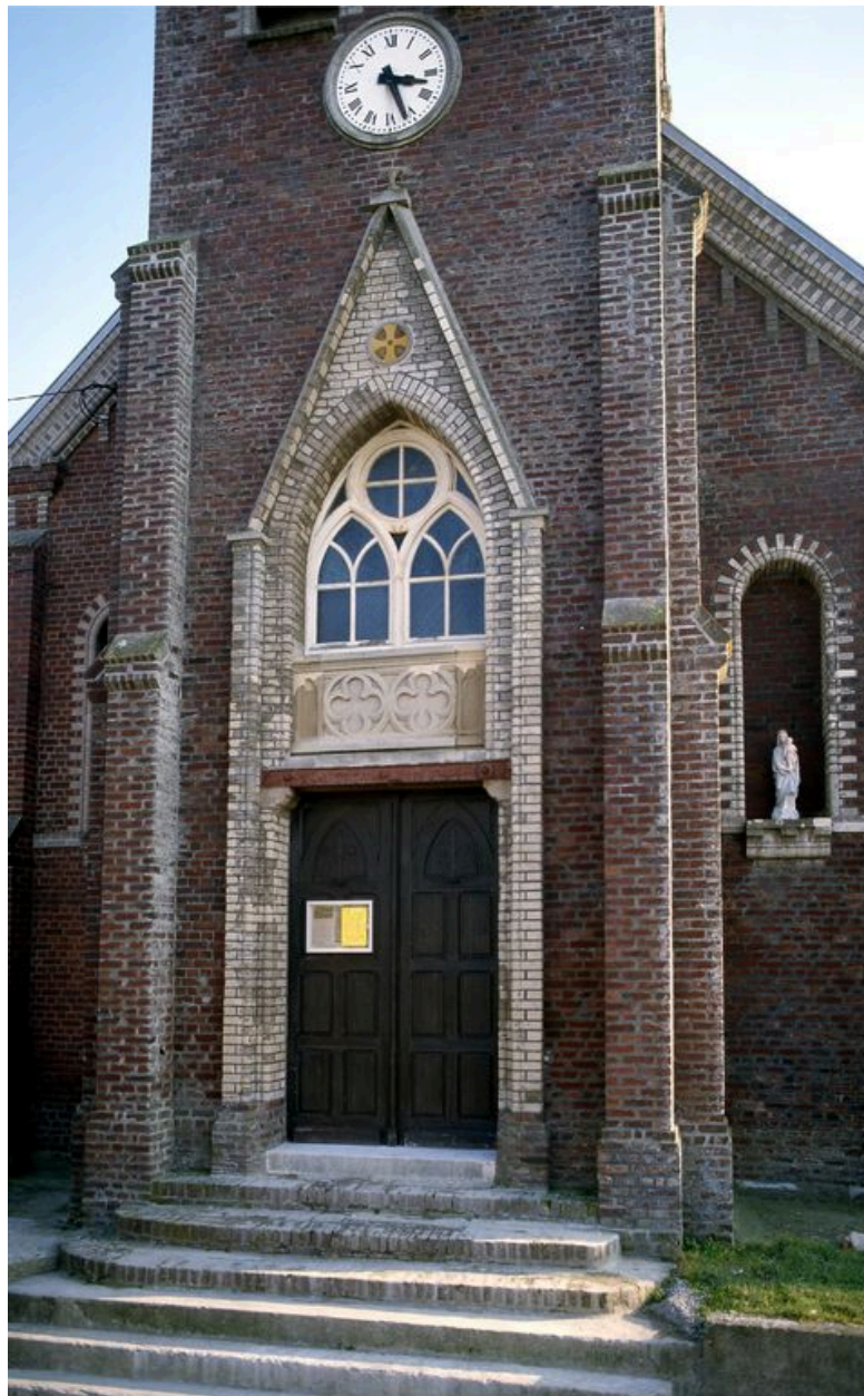
Détail de la façade occidentale.
