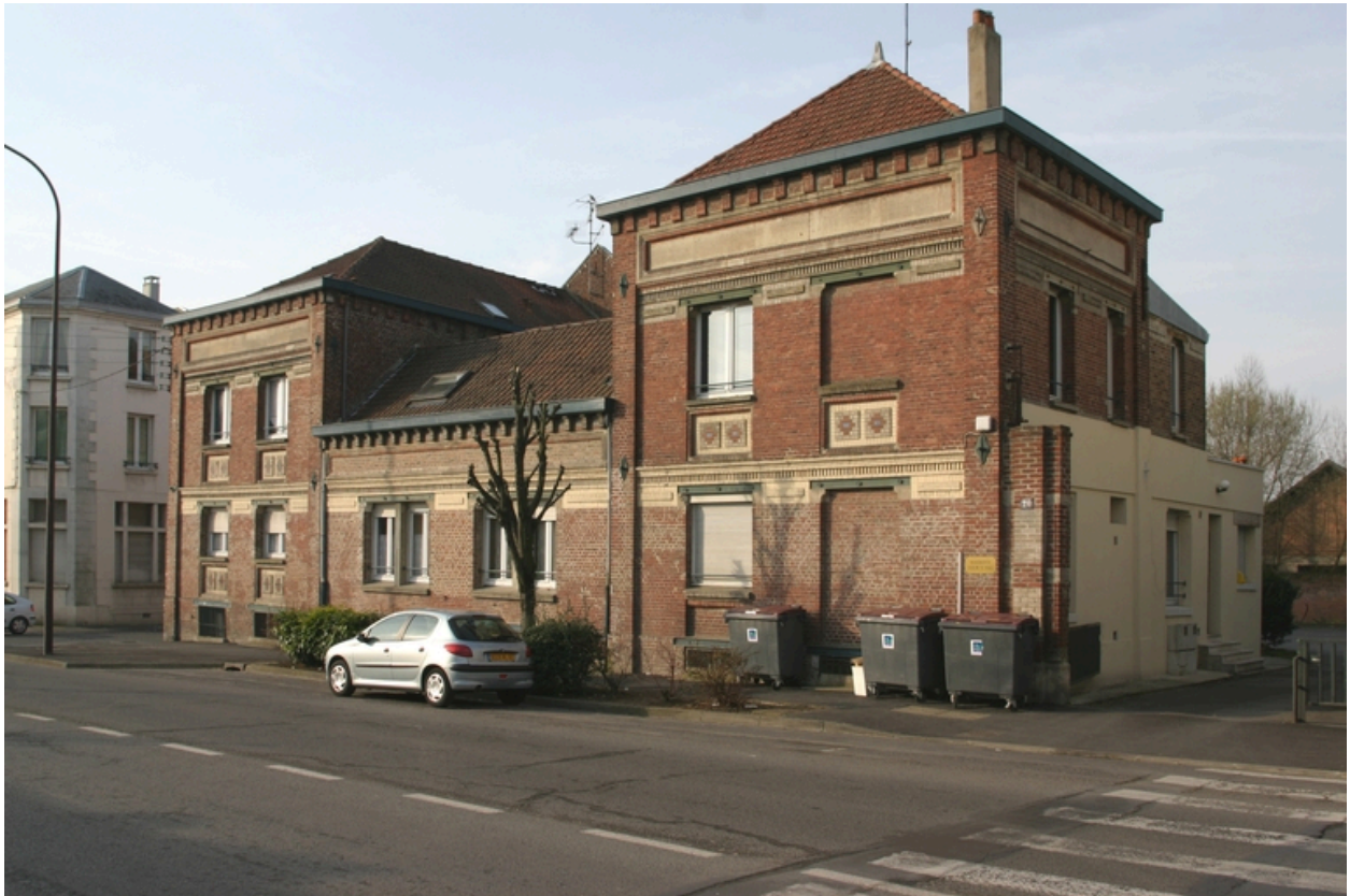
Façade antérieure, rue de Tour-Y-Val.
