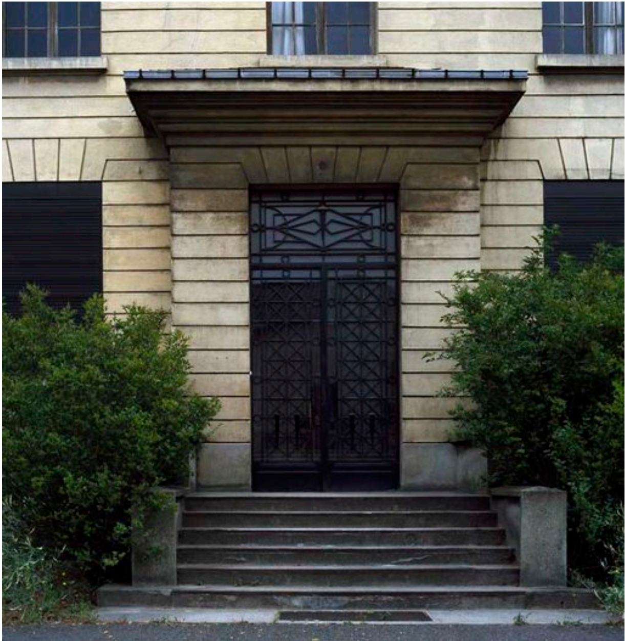
Détail de la porte d'entrée ornée de clous.
