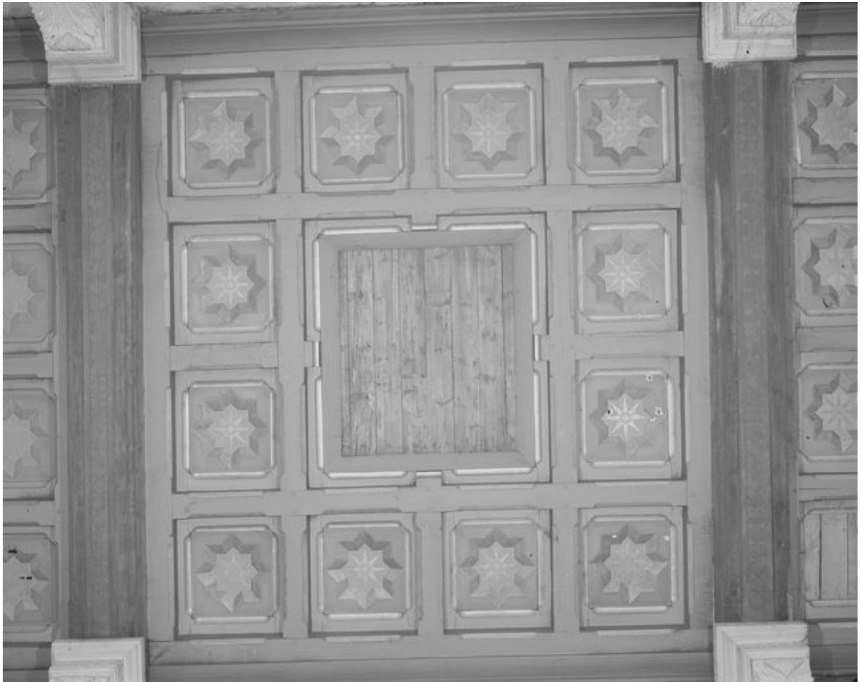
Vue de détail : caisson du plafond des bas-côtés.
