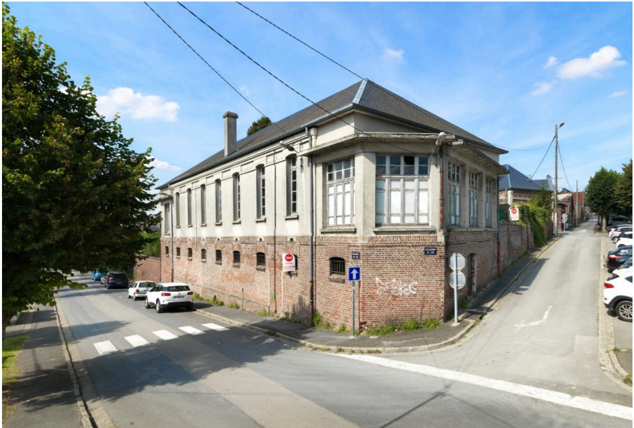
Vue du pavillon construit en 1906 à l'angle des boulevards de l'Est et Gracchus-Babeuf.
