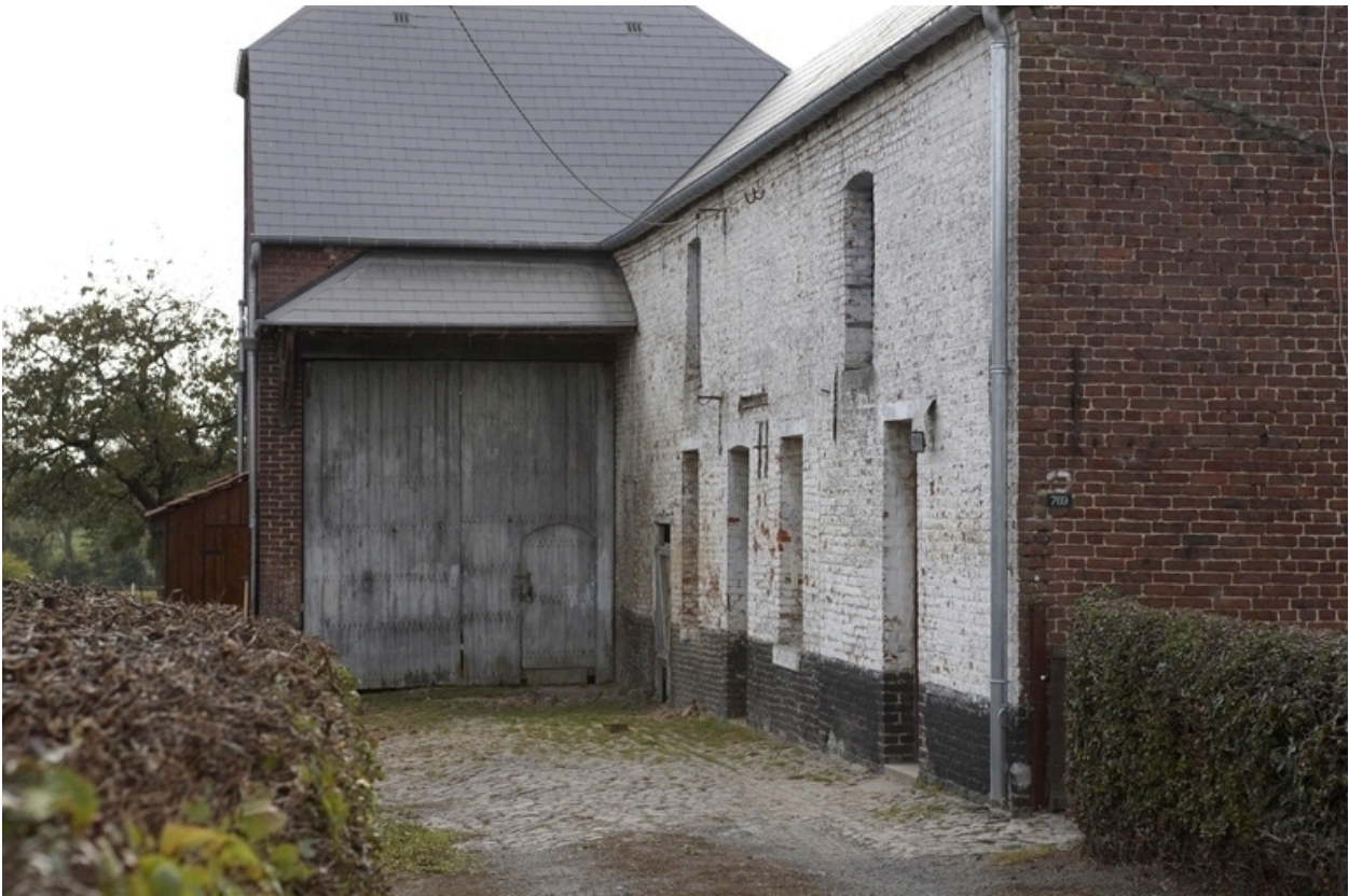
Détail de l'élévation est (le logis et les étables) et de la grange située au sud.
