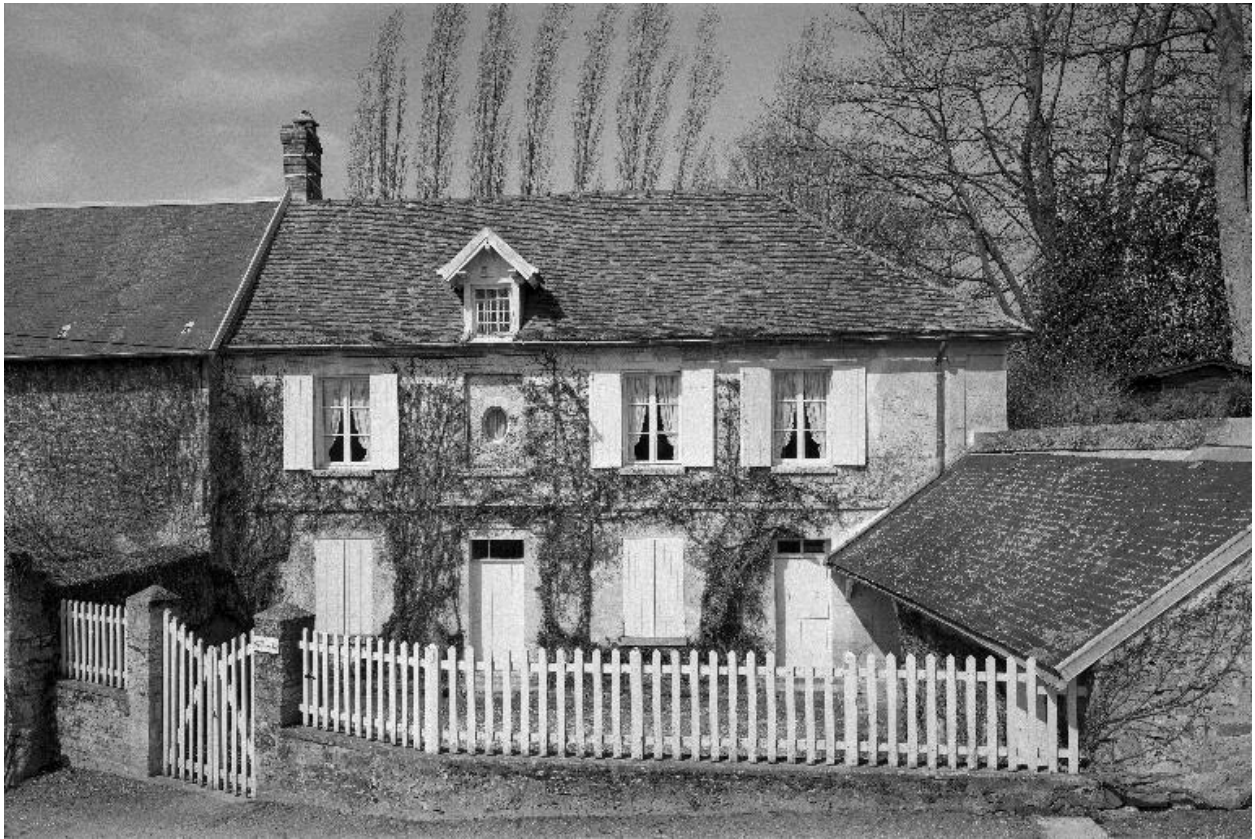
Façade orientale d'une maison, 6 rue de l'Église.
