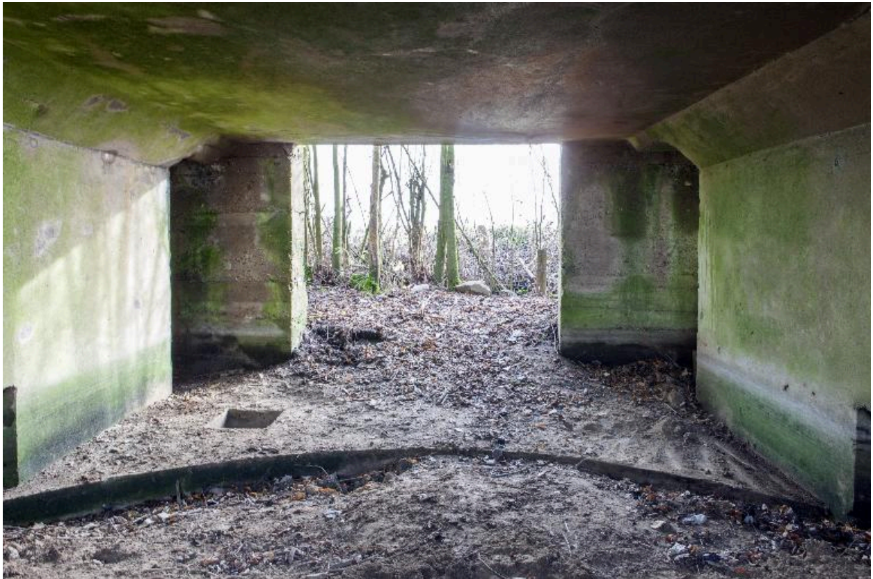
La chambre de tir avant déblaiement, vers le sud
