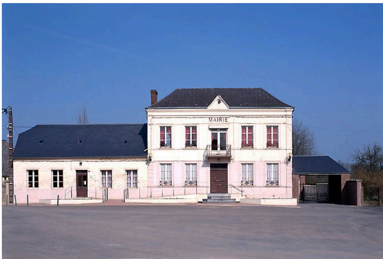
Vue générale depuis le sud-ouest.
