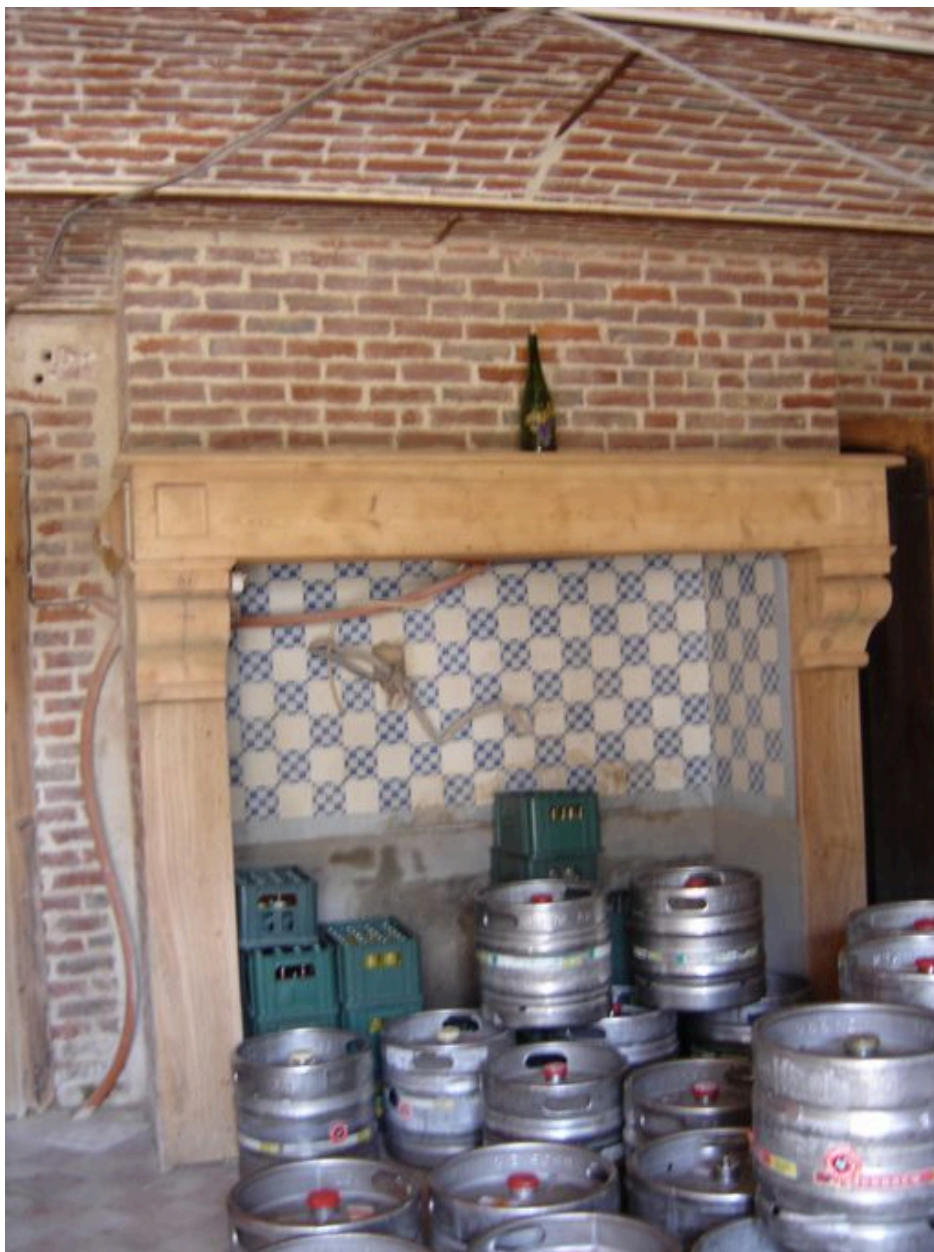
Vue de la cheminée du sous-sol d'un rendez-vous de chasse, partie destinée aux employés de maison.
