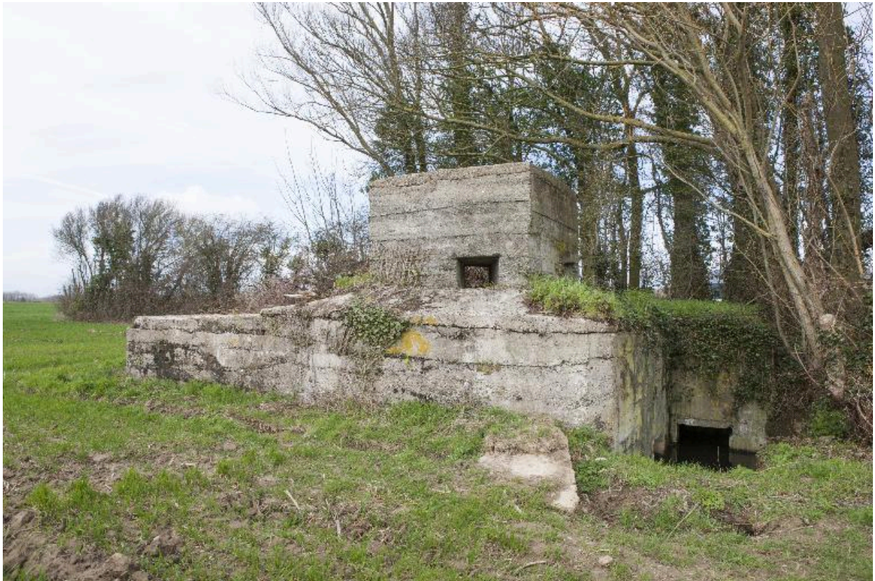
Vue générale, vers le nord-ouest
