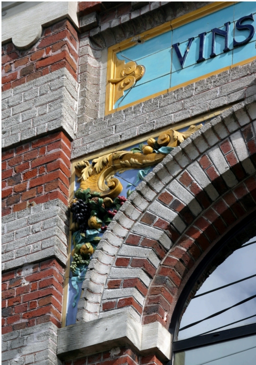
Façade antérieure, détail.
