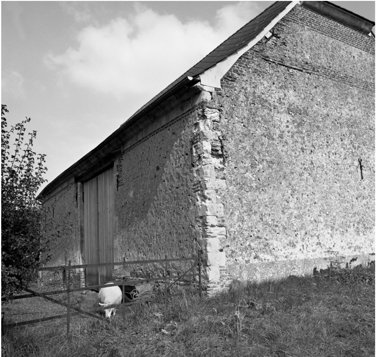
Grange : élévations externes depuis l'ouest.
