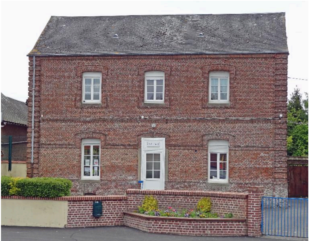
Vue générale depuis la place du Maréchal Leclerc.
