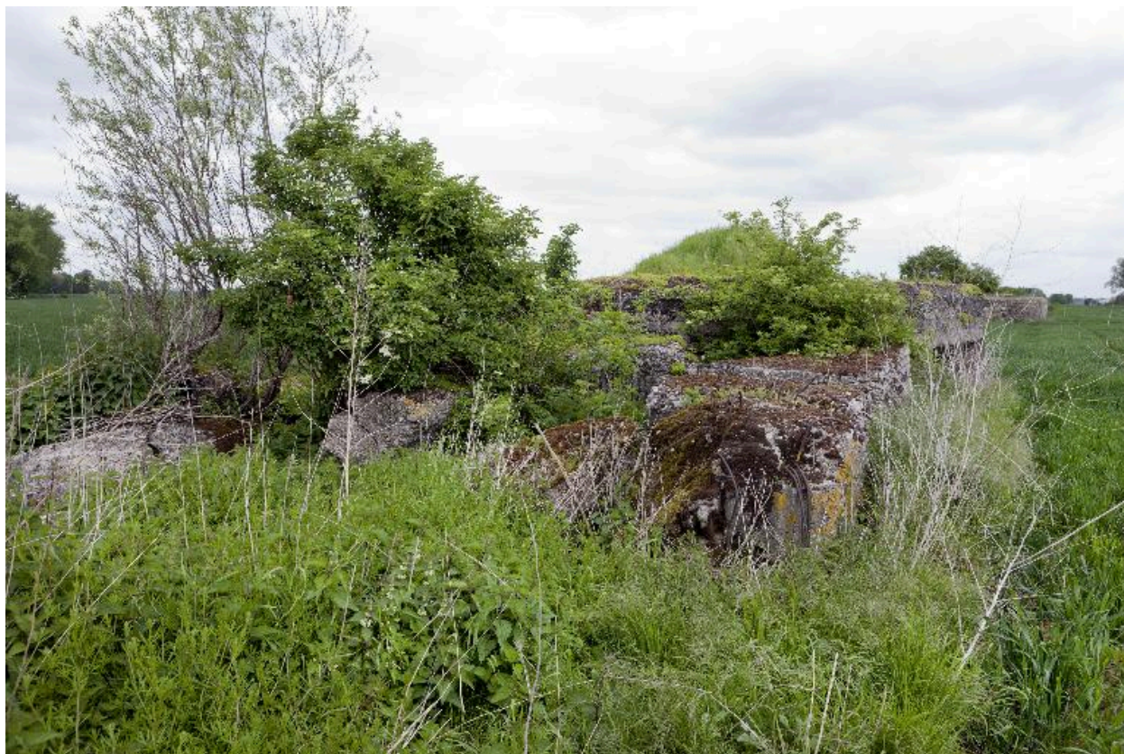
Vue latérale vers l'est. Soute à munitions
