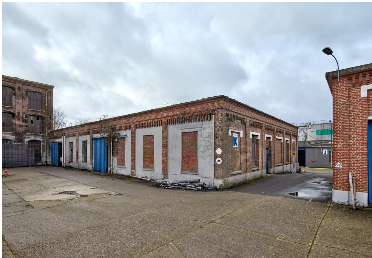
Magasins, vue générale depuis le nord-est (batiment K).
