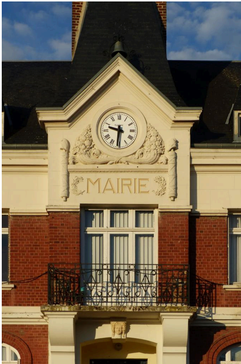
Vue de détail sur la travée centrale.
