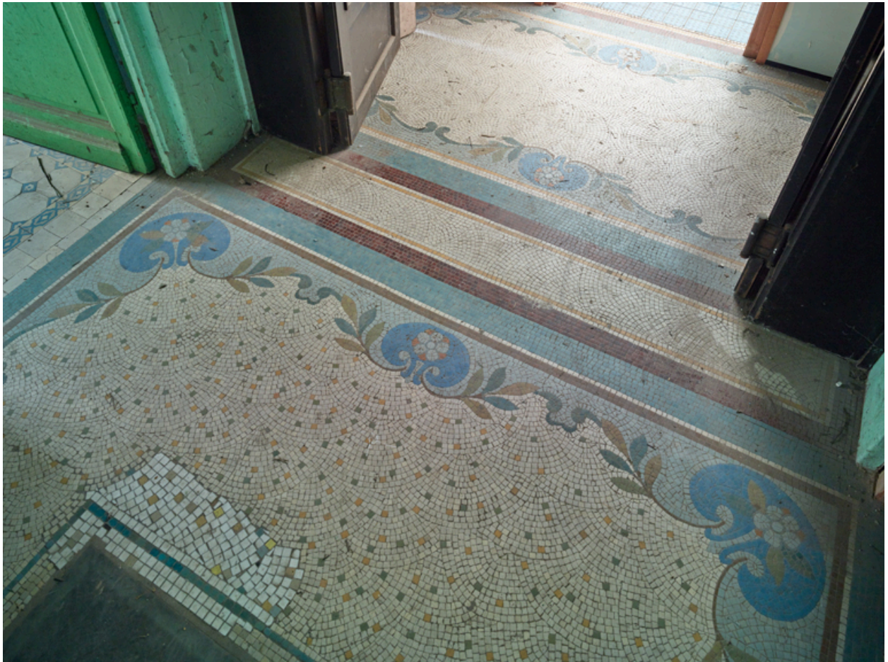
Bâtiment central, rez-de-chaussée. Détail de la mosaïque (entreprise Coilliot) ornant le couloir entre le vestibule et le bassin de natation.
