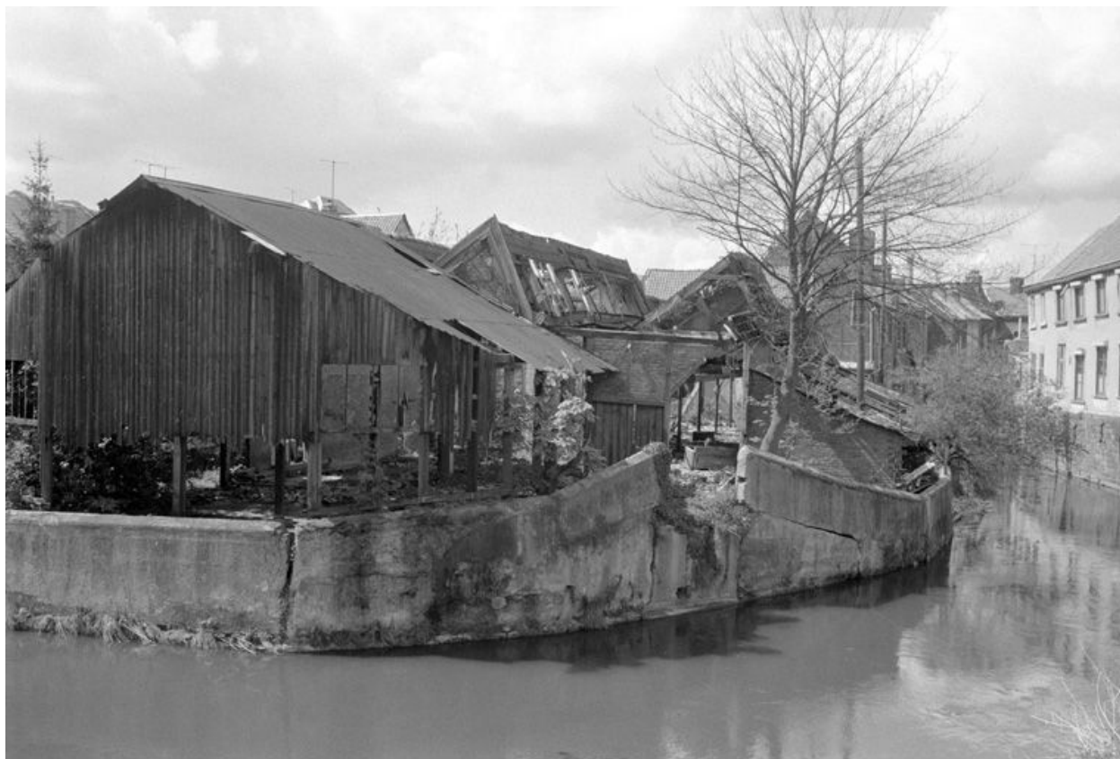
Vue générale de l'usine.
