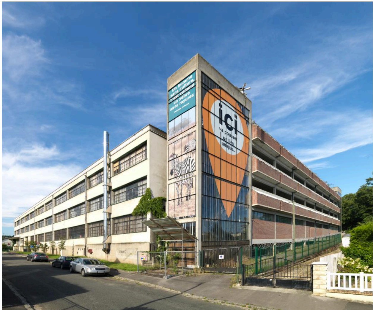
Vue d'ensemble nord-est à la jonction des deux corps de bâtiments du collège.
