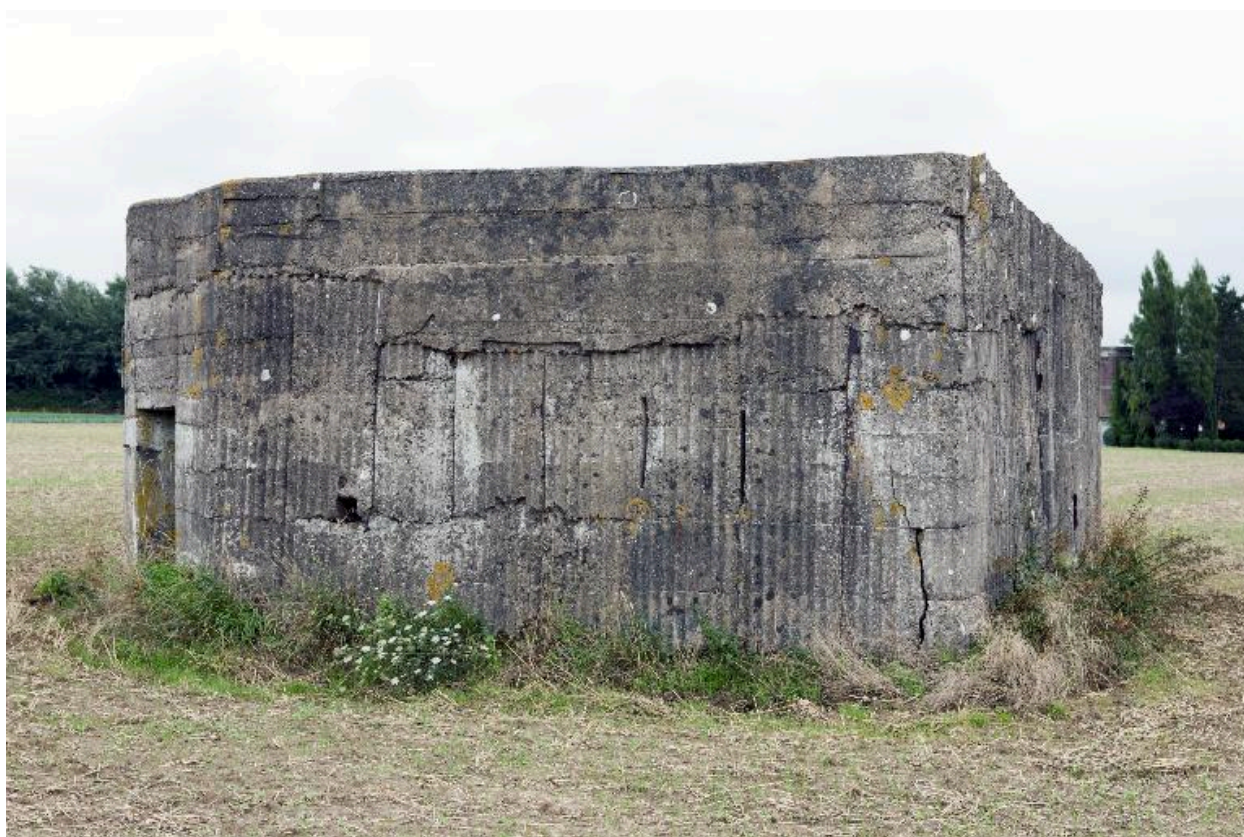
Vue latérale nord
