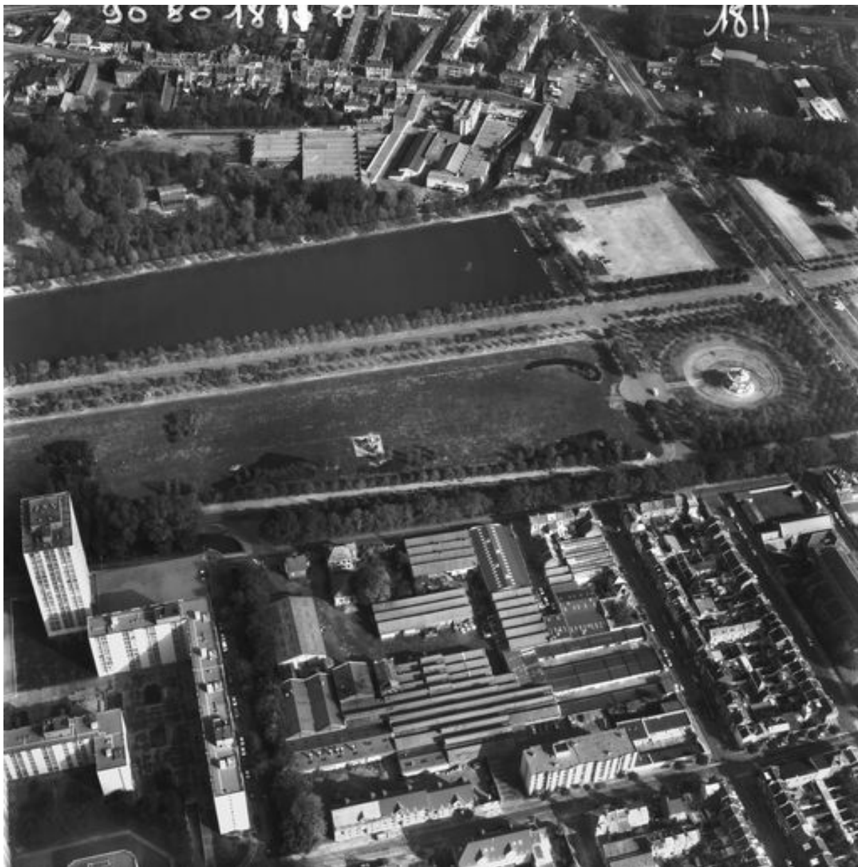
Vue aérienne, flanc sud.
