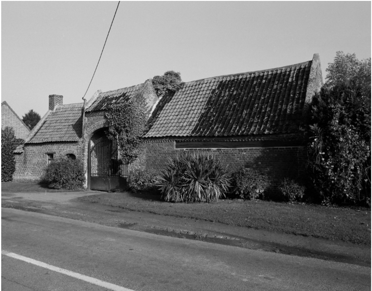
Ferme, 1087, rue de Lelier, le portail.
