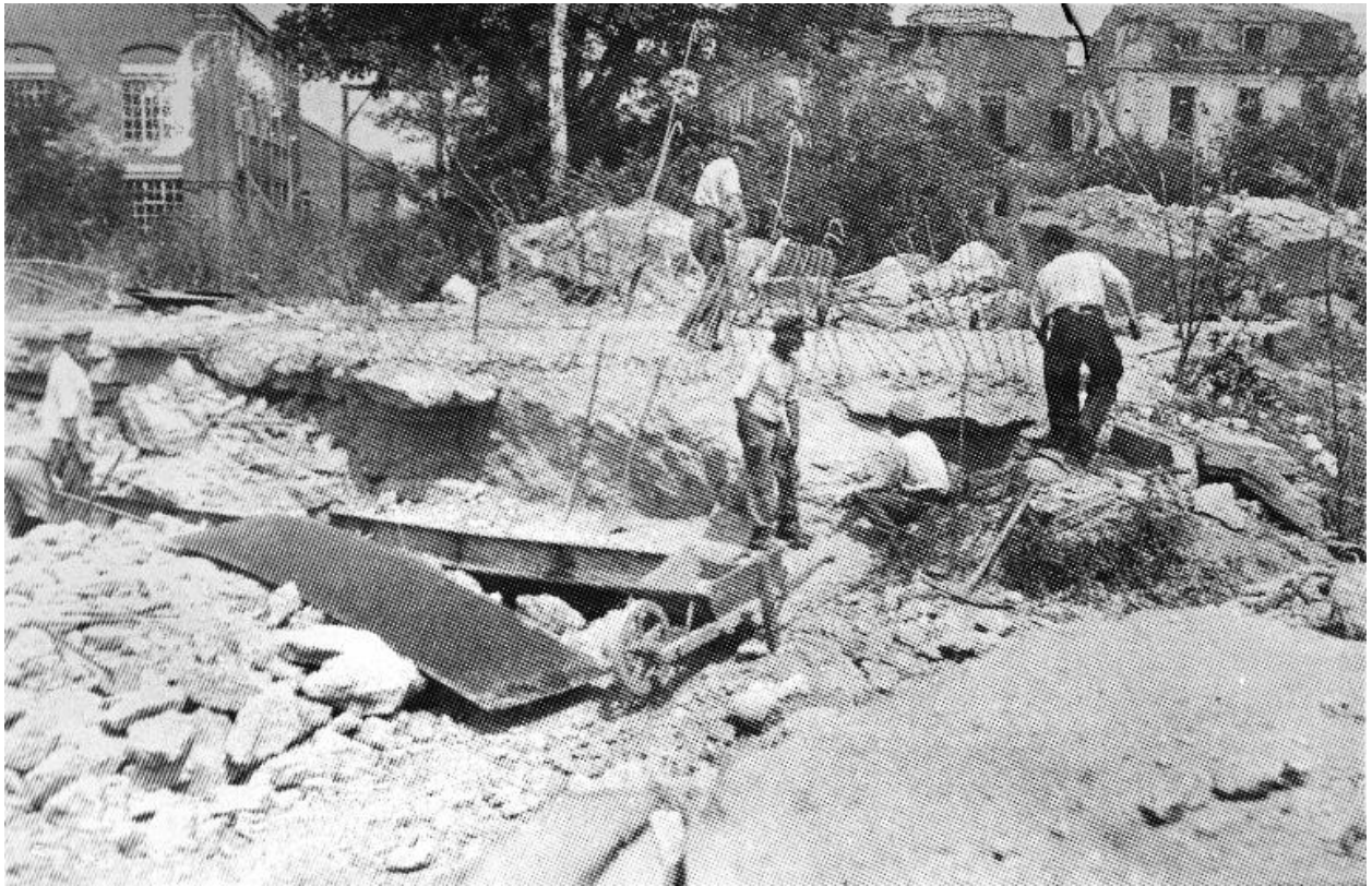
Déblaiement de la cour de la sucrerie Bernard. Non daté
