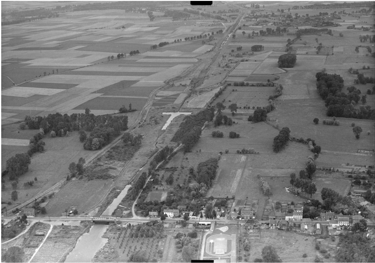
État du site écluse n°2 de Marquion (Pas-de-Calais) en 1958 avant la reprise des travaux en 1965 (IGN. Photothèque Nationale. 1958).
