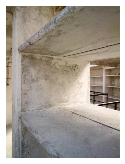
Bâtiment du dépôt, troisième étage : détail d'un rayonnage en béton armé. Chaque plateforme horizontale repose sur deux supports verticaux, eux-mêmes posés le long des piliers de béton.
