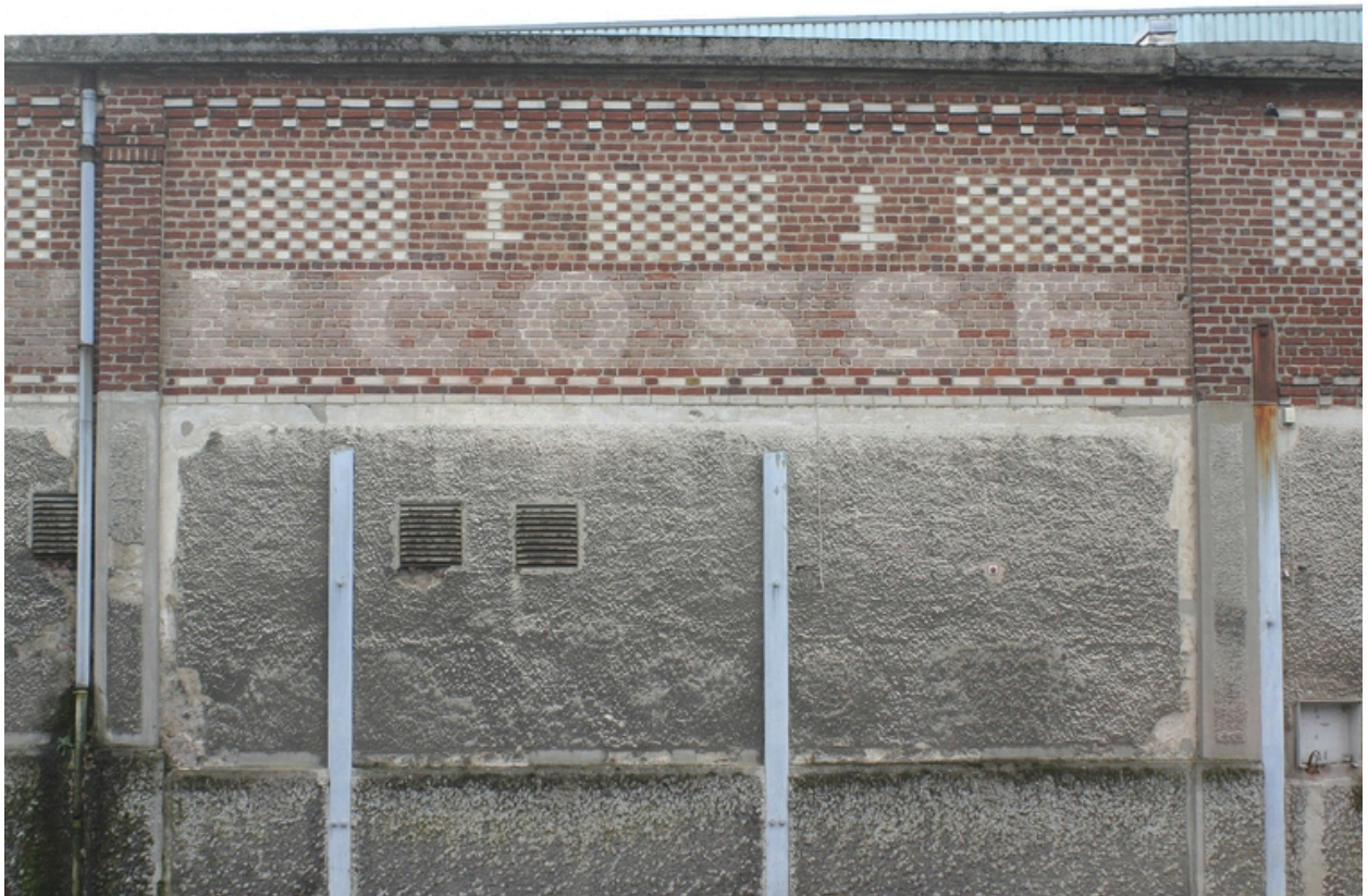
Détail du mur d'enceinte, rue de Guise.
