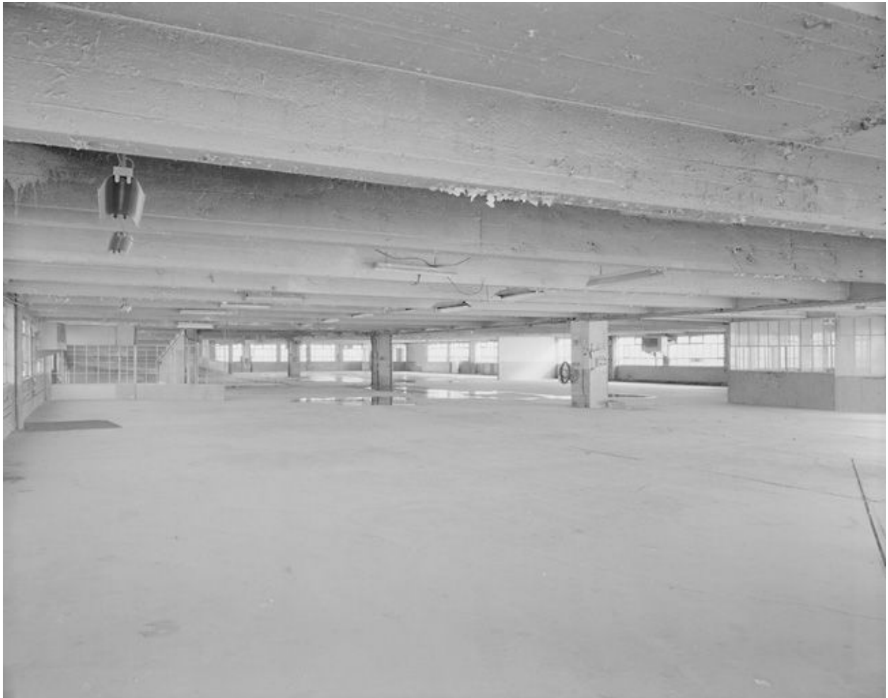
Vue d'ensemble du niveau 3.
