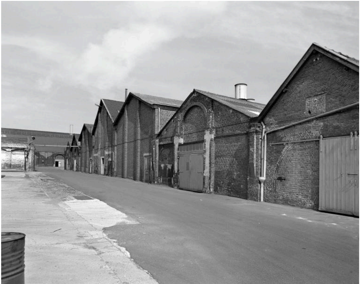
Vue extérieure des bâtiments industriels.
