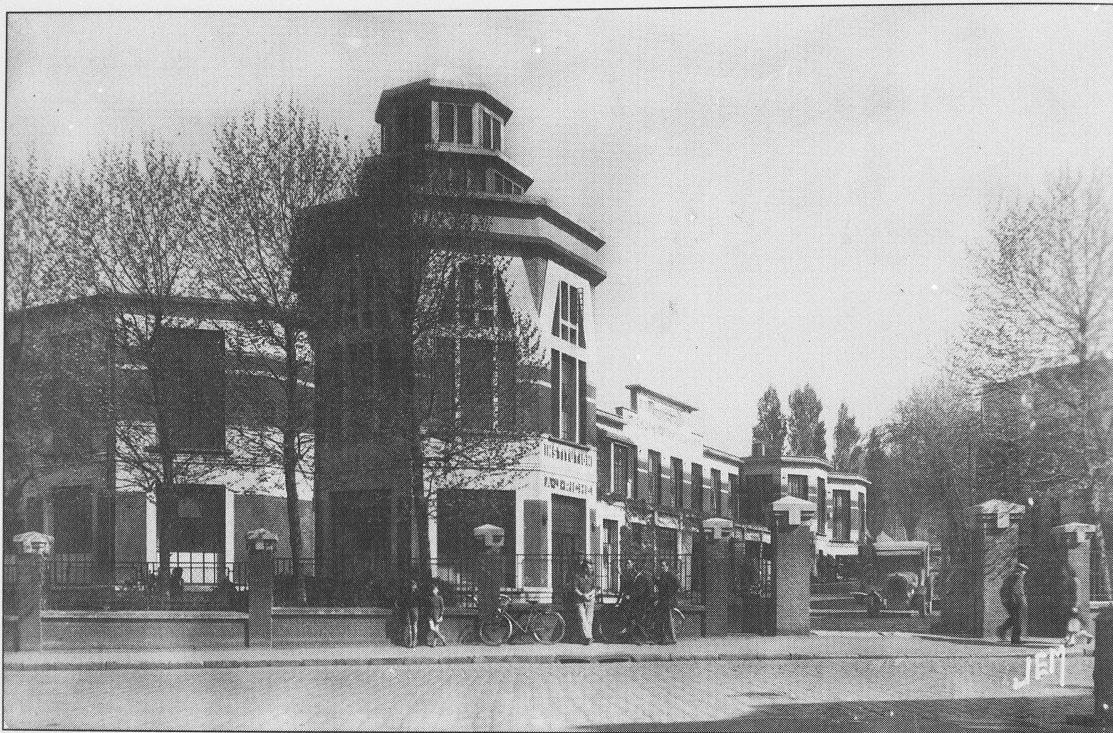
L'hôpital de Jeumont, prévu à l'origine pour être un hôpital-hospice-crèche, fut construit en 1926 grâce en partie au legs d'A.-J. Riche. Il est l'œuvre d'Adolphe Danis, architecte de renom, né à Jeumont le 27 décembre 1886.
