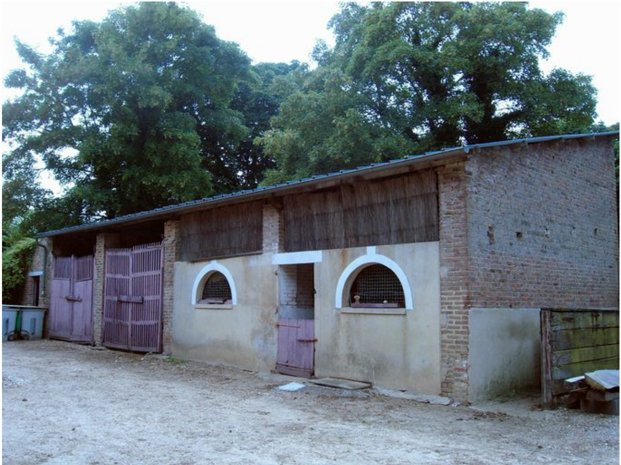
Vue de l'abri à voitures.
