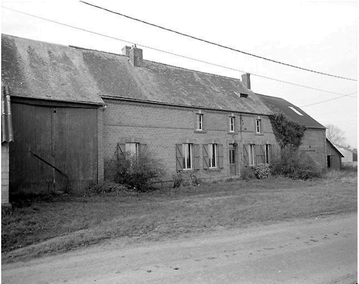
Façade est du logis, avec l'entrée de la grange traversante.
