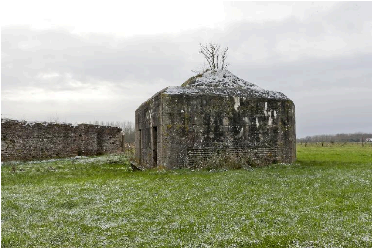
Vue générale, vers le sud-ouest
