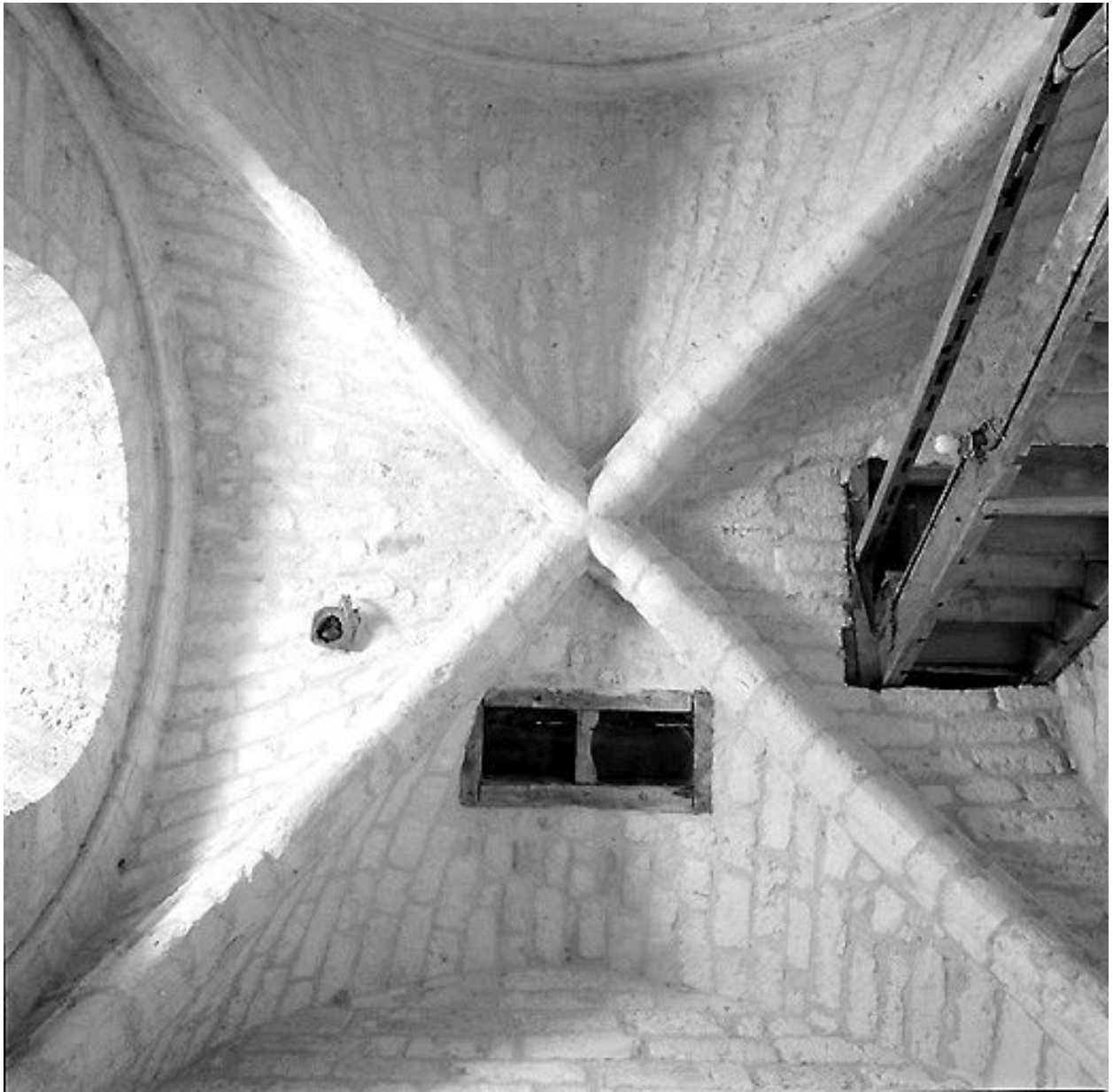
Vue de la voûte d'ogives de la salle basse du clocher.
