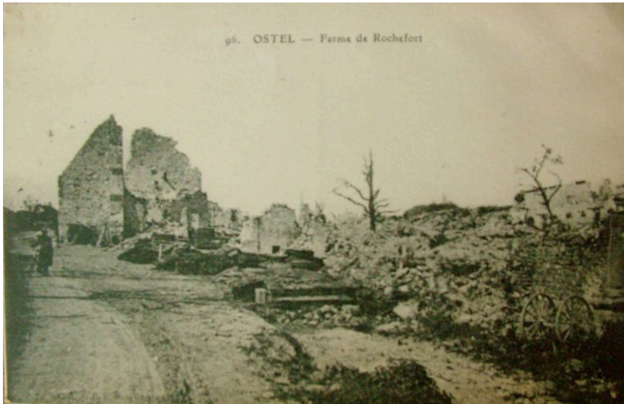
Vue de la propriété en ruines (coll. part).
