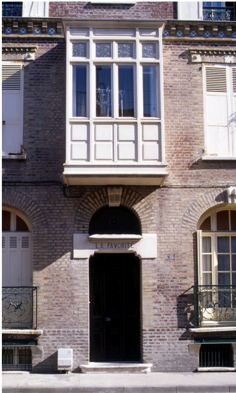
Détail de la travée d'entrée de la maison dite La Favorite, avec bow-window en surplomb.
