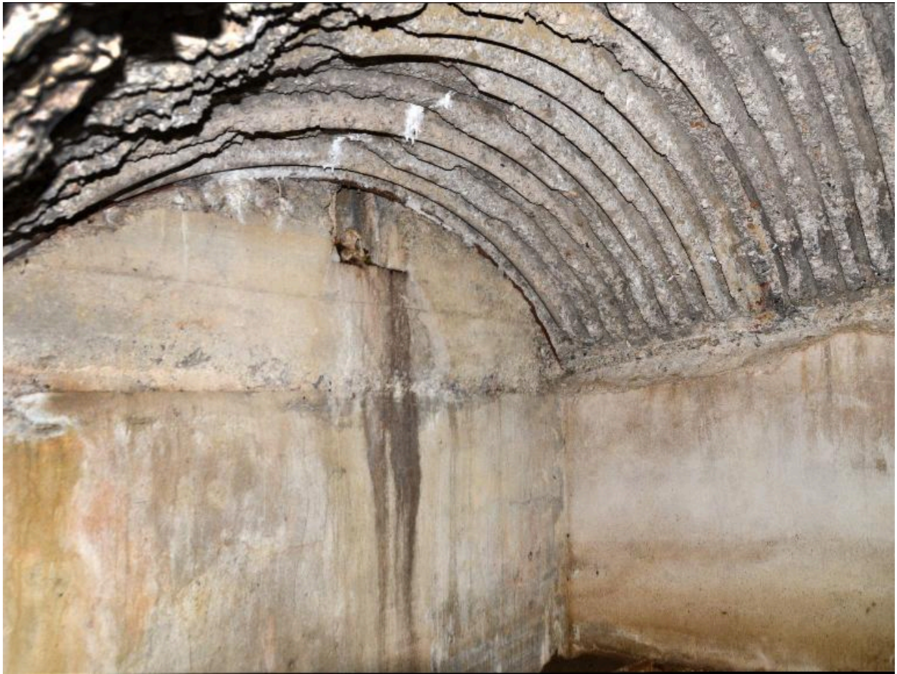
Seconde salle nord. Empreinte de coffrage en tôle ondulée et pignon ouest avec son aération
