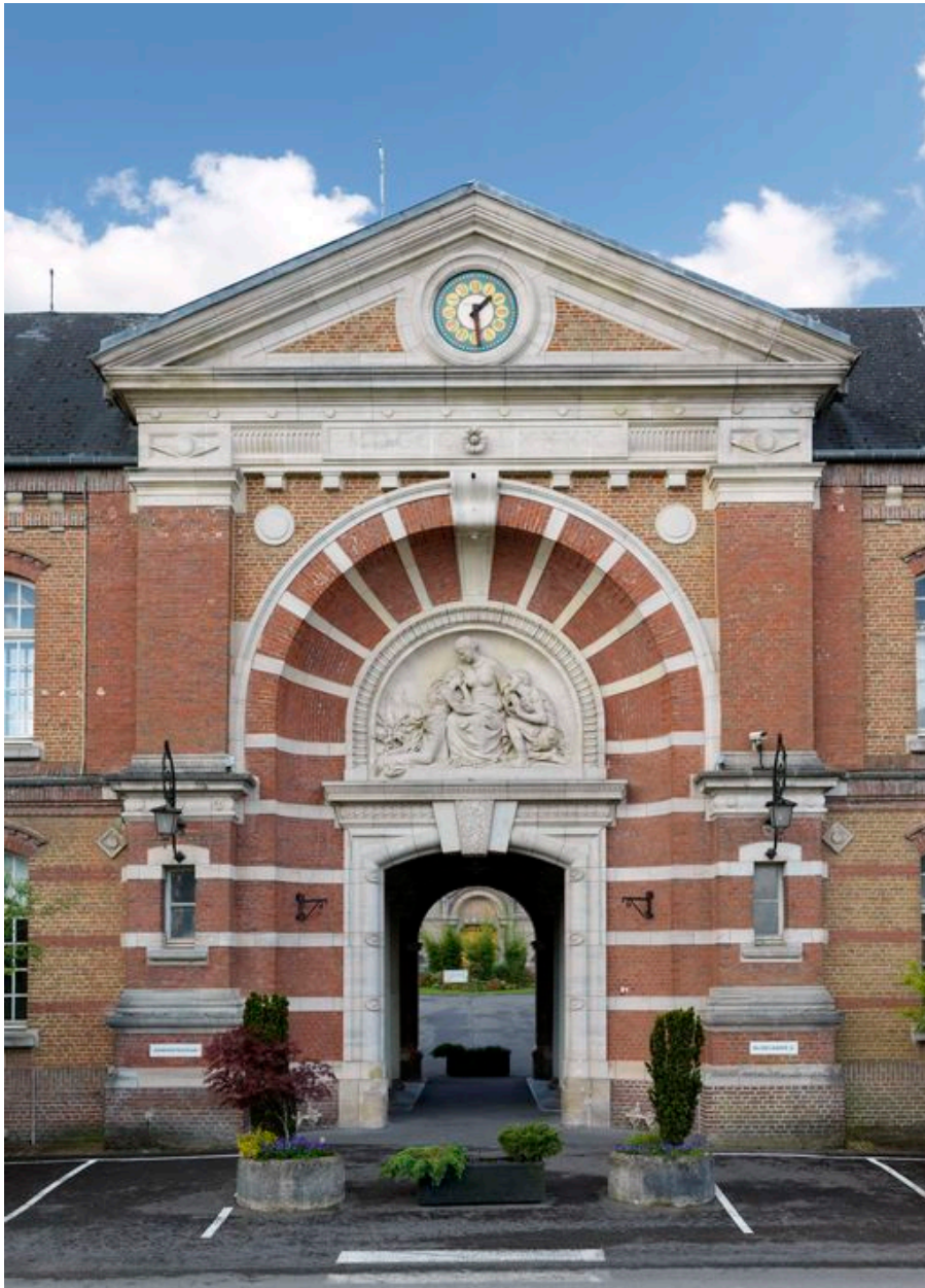
Travée centrale du bâtiment d'administration. Façade nord.
