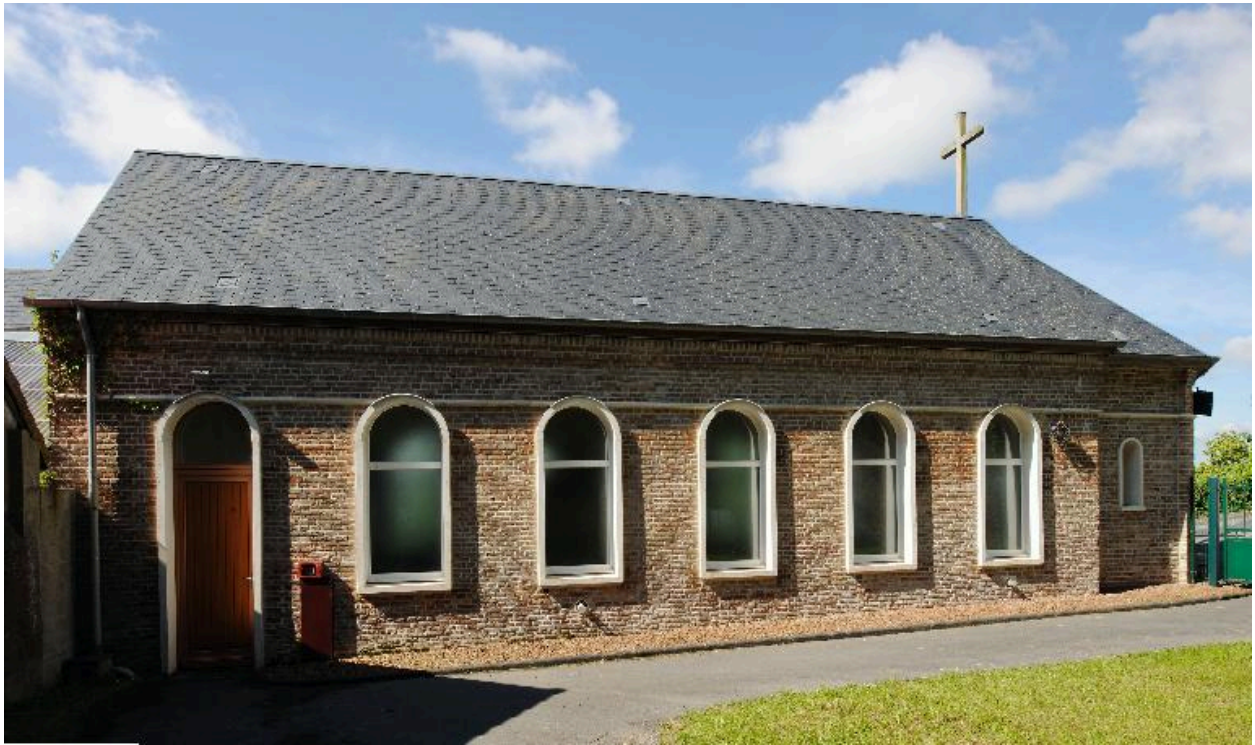
Façade sur cour.
